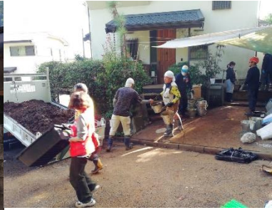
秦野市土砂災害現場作業
